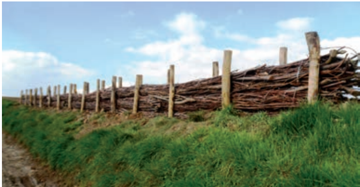
Les fascines sont des fagots de branchages disposés sur des parcelles en vue de limiter l'érosion des sols, de freiner le ruissellement et de favoriser la sédimentation des terres.
