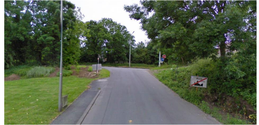
Débouché de la rue Dauphine sur la N5
